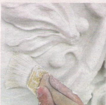
Alte Fassaden sanieren: malkraft ist der Profi für Stuckverlegungen und Kalkfarbtechniken.
