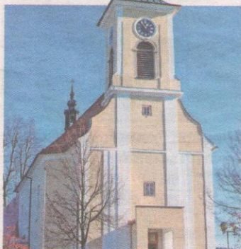
Die Pfarrkirche Kollerschlag glänzt neu. Die Fassaden-Sanierung erfolgte durch malkraft.
